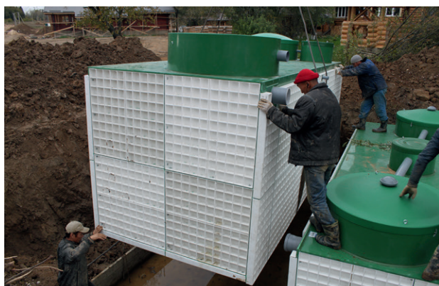
Рис. 4. Монтаж блоков на плиту-основание (на фото слева) и смонтированные блоки (на фото справа)
