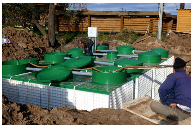
Рис. 4. Монтаж блоков на плиту-основание (на фото слева) и смонтированные блоки (на фото справа)
